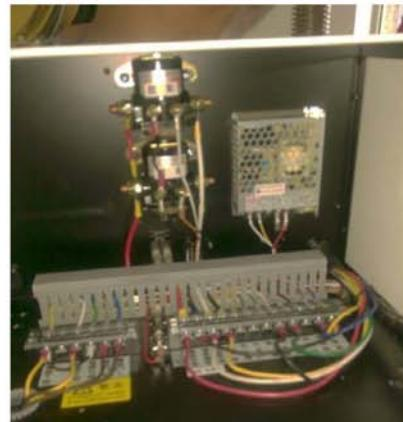
若繼電器及停車閥均正常則檢查停車閥拉桿的長度是否太長並做調整。若電子調速器機組，則檢查調速控制器的Actualator是否斷電或調速器的調速推桿組合是否卡住，調速推桿會卡住的原因大部分是機組太久沒有運轉，只要將調速器拉桿用手推動，直至拉桿能正常動作即可。
